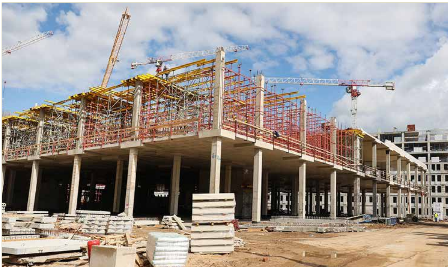
Ежедневно на строительной площадке задействовано более 280 рабочих и 14 единиц специальной техники, включая шесть башенных кранов. Кампус станет частью концепции «Город-Университет».
